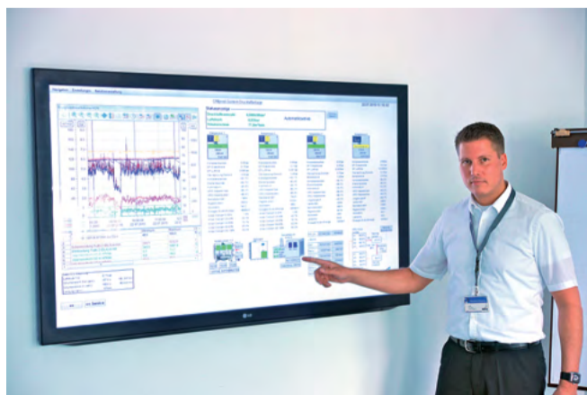
Die Betriebsdaten der Druckluftstation wurden als Livedaten in die Gebäudeleittechnik bei Hettich-ONI eingebunden. Dies ermöglicht eine ständige Überwachung der Zustände.
